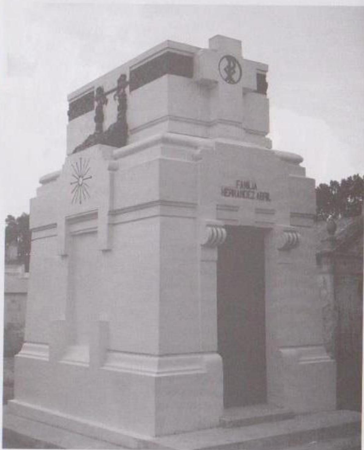
El mausoleo de la familia García Archila, en el cuadro 14, es un ejemplo de Art Decó en materiales tradicionales ya que, por el deteriorado estado de conservación, se puede apreciar la construcción en ladrillo. La decoración se limitó a los extremos, donde se colocaron pilastras con decoración en estrías y la cruz de concreto está recubierta
